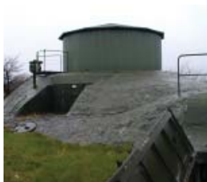
Nedgång till huvudanläggning. Bakom kupolen finns radarantennen
